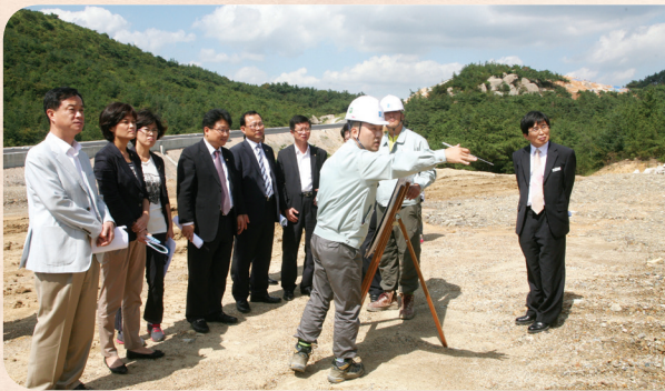
▲ 제135회 임시회, 울산외국어고등학교 옹벽 복구 보강공사 현장활동 (2012. 9. 19)
