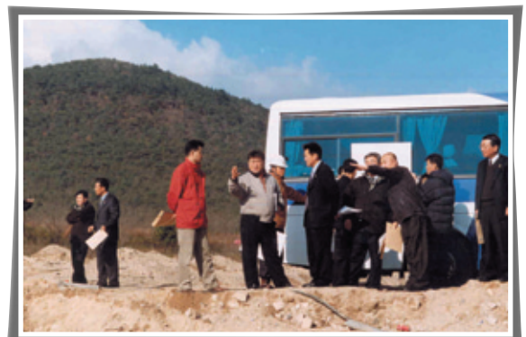
행정사무감사 현장 확인 (동천강 수해복구 공사 현장)(2004.12.5)
