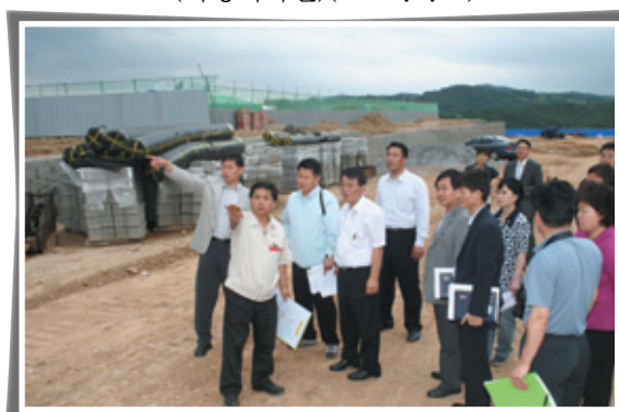
행정사무 감사 준비를 위한 현장 확인 (달천동 I-PARK 공사현장)(2007.6.28)
