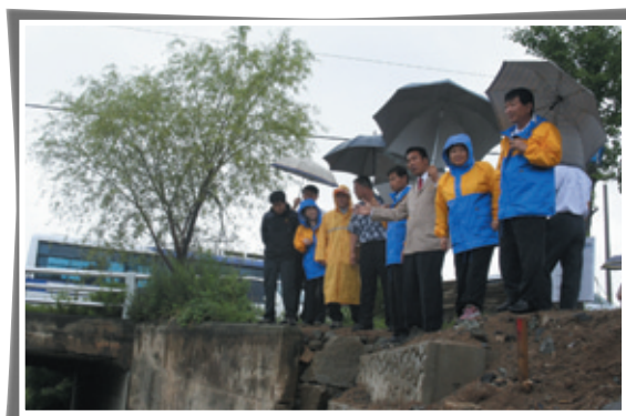
행정사무감사 현장 확인 (명춘천 수해복구 현장)(2007.7.13)
