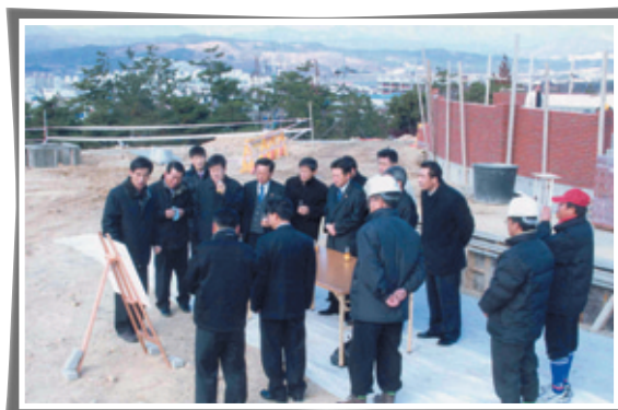
행정사무감사 현장 확인 (효문운동장 조성공사 현장)(2005.12.3)
