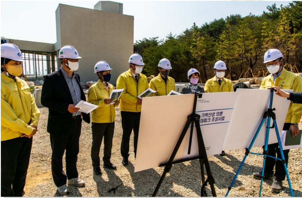
| 기박산성 의병테마파크 조성 현장 방문 |
