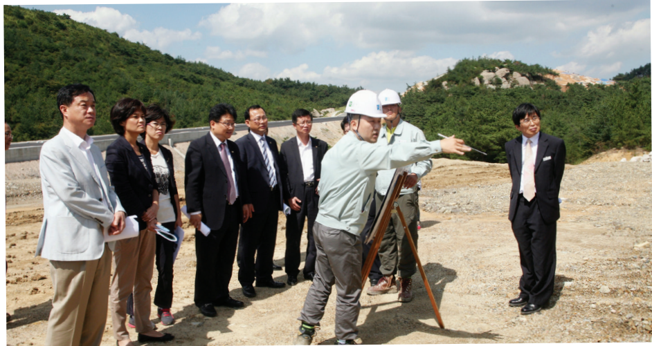
울산외고 용벽보강공사 현장점검(2012. 9. 19)
