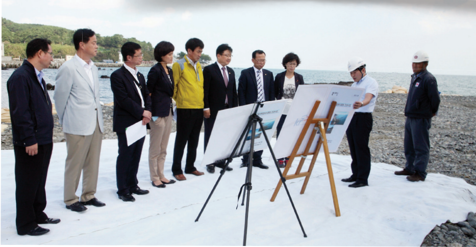
당사해양남시공원 조성공사 현장점검(2012. 9. 19)
