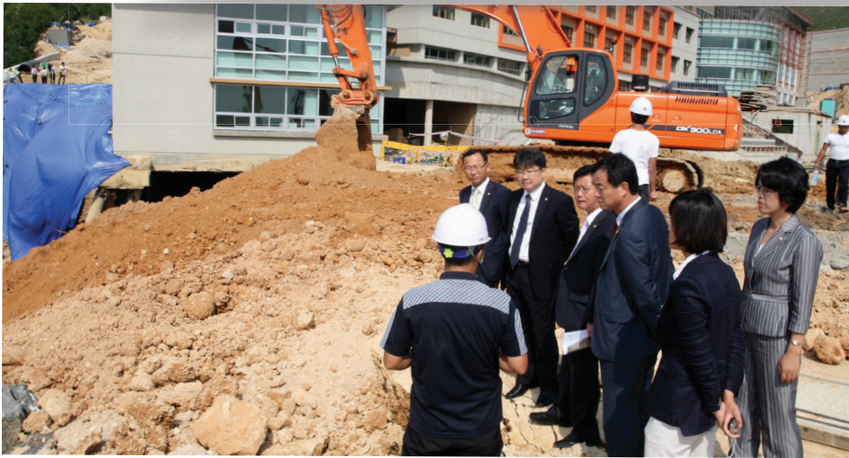
울산외고 건설현장 점검(2010. 9. 9)
